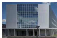
新研究棟(滋賀県草津市)
