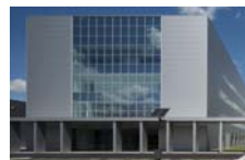
新研究棟 (滋賀県草津市)
